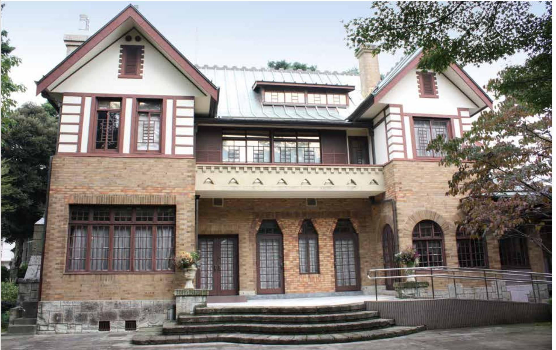
煙突のデザインが印象的なこの洋館が造られたのは大正末期の頃。作家・山本有三は昭和11年から10年間暮らした。基礎部分は大谷石を積み上げ、1階部分の外観はスクラッチタイルで覆い、2階外壁は木組みに漆喰、2段の勾配をつけたギャンブレル屋根、特徴的な3本の煙突などモダンな様式と正統派の様式とが随所に混在している。(9面に関連記事) 写真提供:三鷹市山本有三記念館
