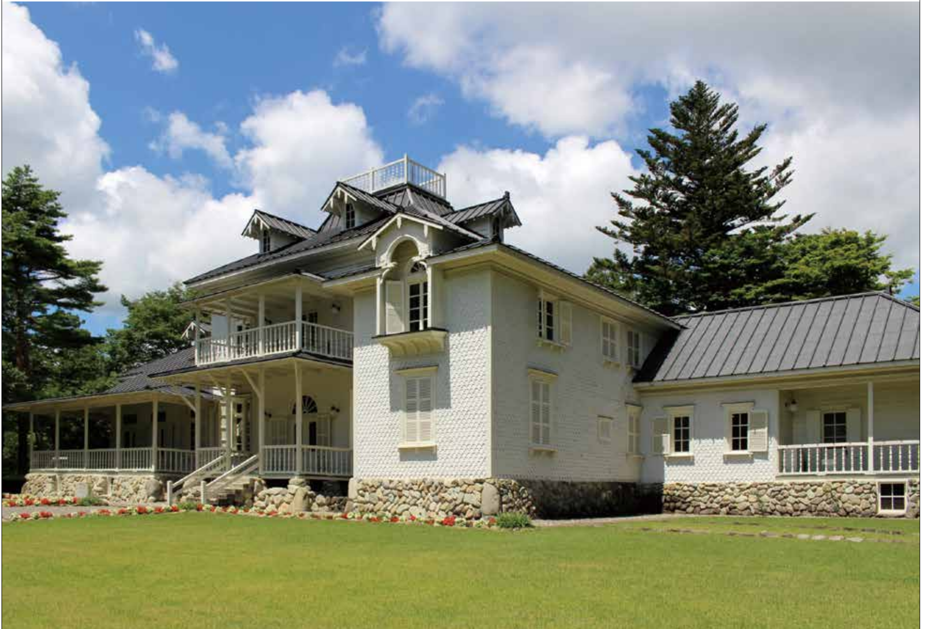
栃木県北部。那須野が原は多くの華族によって開墾された土地。青木農場もそのひとつ。並木道のアプローチを抜けると白く壮麗な洋館が現れる。高形と鱗形の壁材を使い、軽快な印象を与える外観。とくに、寄棟屋根の中に設けられた窓が特徴的だ。(9面に関連記事) 写真提供: 那須塩原市教育委員会
