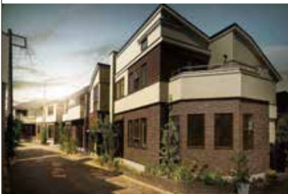
「ファインコート赤堤二丁目」。総戸数8戸。街並写真(平成29年3月撮影)
