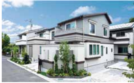
「ファインコート武蔵小金井パークアリーナ」 街並み写真(2023年8月撮影)
