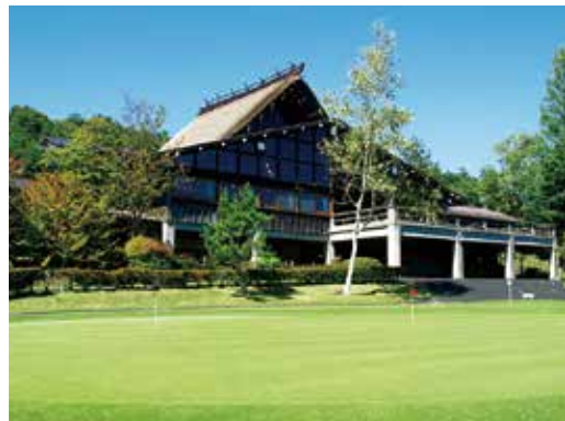
クラブハウスコース側 合掌造りのクラブハウス。萱葺き屋根で重厚な雰囲気醸す。
