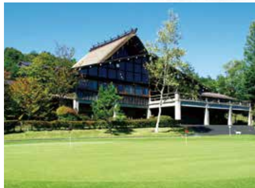
クラブハウスコース側 合掌造りのクラブハウス。萱葺き屋根で重厚な雰囲気醸成。
